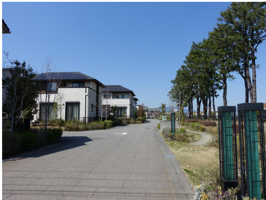
宅地整備時に無電柱化を実施(つくば市)
